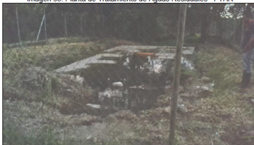
Imagen 63. Planta de Tratamiento de Aguas Residuales - PTAR
